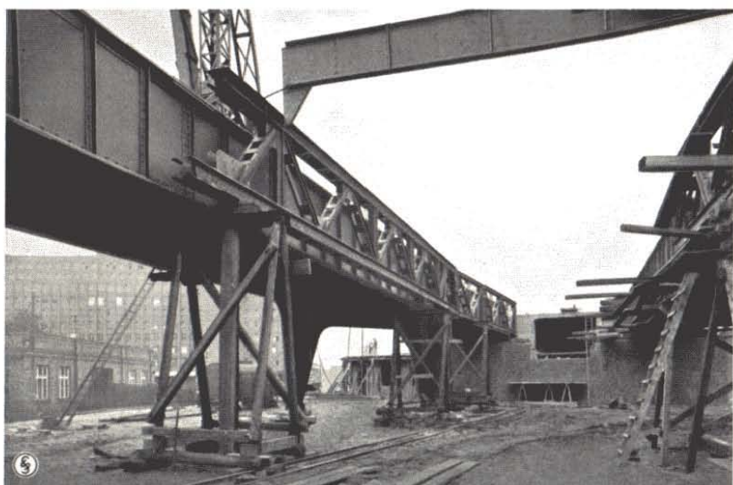
Bild 24 a. Bahnhof Siemensstadt: Einbau der Bahnsteigtragkonstruktion innerhalb der Gleistragkonstruktion
