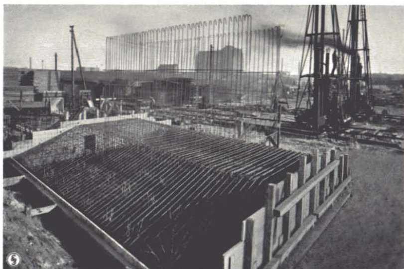
Bild 19. Bahnhof Wernerwerk: Bewehrung der Eisenbeton-Kopfplatte eines Fundamentes am Nordausgang
