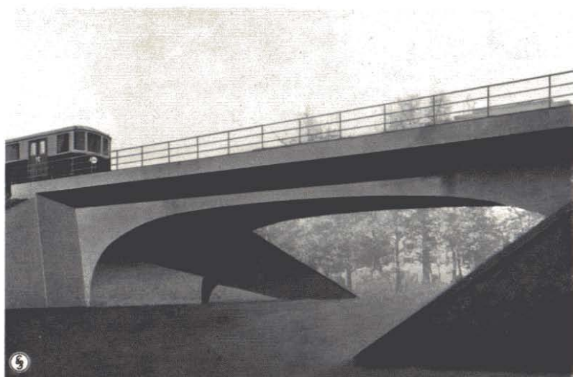
Bild 23. Eisenbeton-Zweigelenkrahmenbrücke über die verlängerte Brunnenstraße
