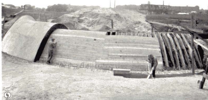
Bild 15c. Schmutzkanal-Überwölbung: Ansicht (zur Hälfte in der Schalung und zur Hälfte betoniert)
