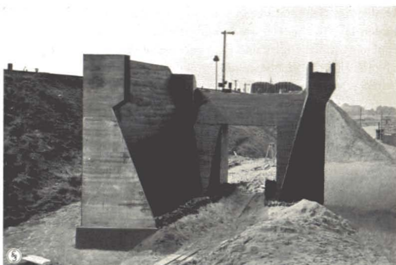
Bild 11. Ringbahnkreuzung: Ostwiderlager fertig, ohne Hinterfüllung
