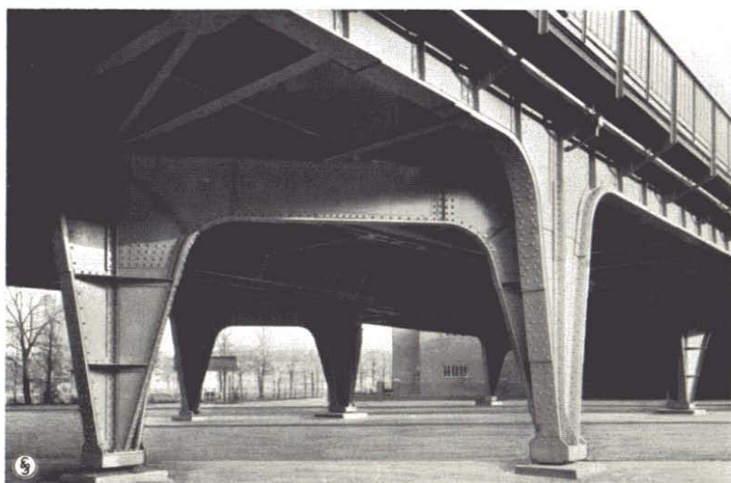
Bild 24b. Bahnhof Siemensstadt: Blick durch die Brücken über den Rohrdamm
