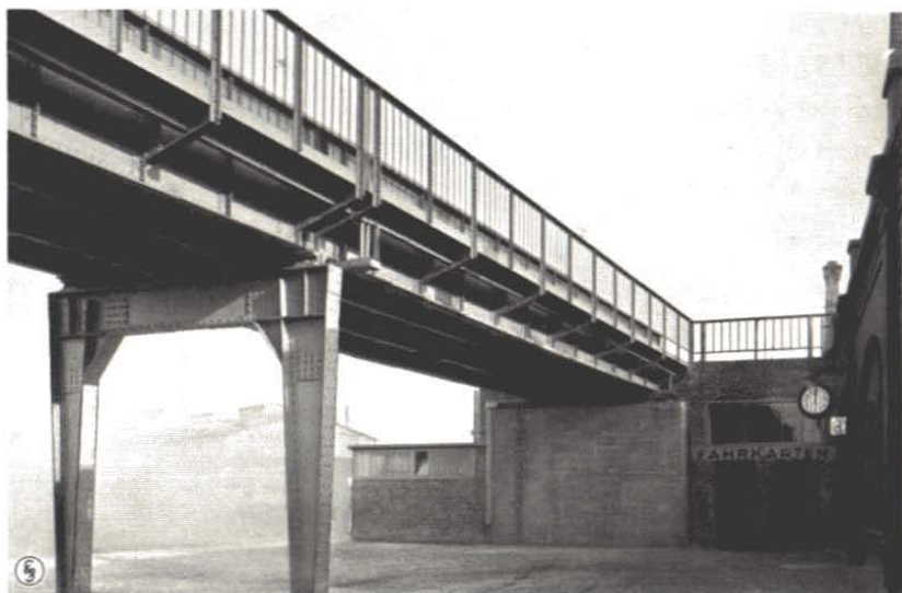
Bild 7. Bahnhof Jungfernhöhe: Neuer Vorbau am Westeingang mit Widerlager der Oberen Spreebrücke
