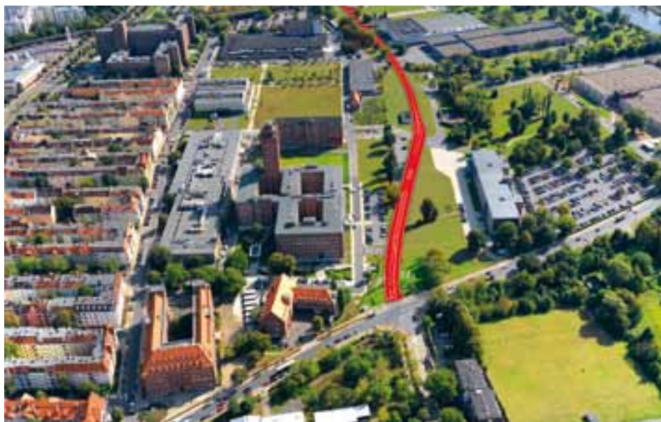
Die neue Straße wird den Rohrtdamm mit dem Siemensdamm verbinden
