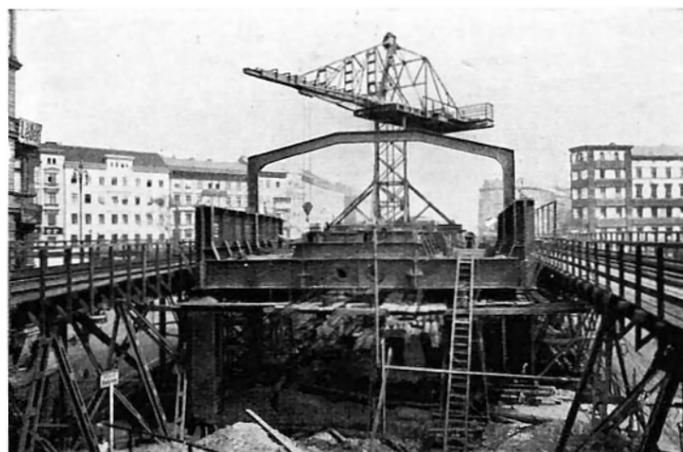
Abb. 34. Umbau des Hochbahnhofes Kottbusser Tor.
